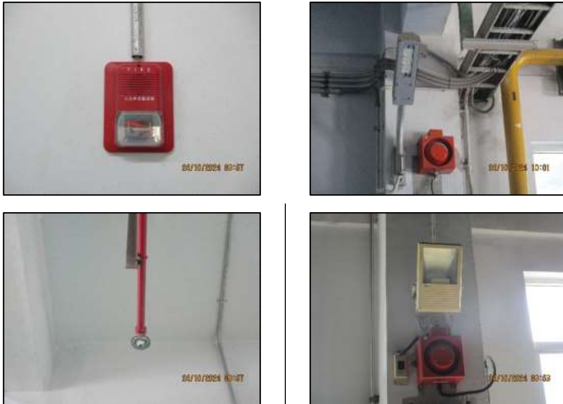
ภาพที่ 2.14 ระบบตรวจสอบตรวจจับ และสัญญาณเตือนภัยแบบอัตโนมัติภายในโครงการ
